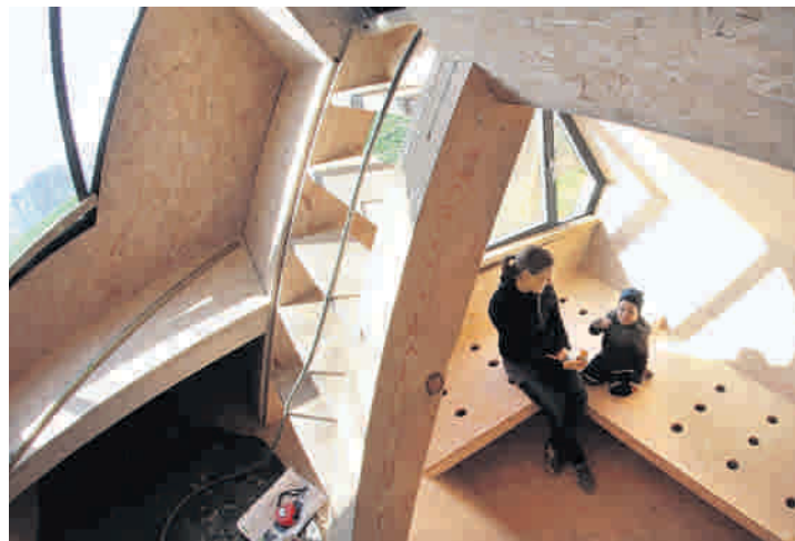
Ungewöhnlich: Architektin Stefanie Henneke und Hannes sitzen in einem im Ausbau befindlichen Schlafraum einer Wohnwabe. Foto: dpa
